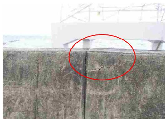
写真6 参考:アルカリ骨材反応の特徴的な状況(2)
