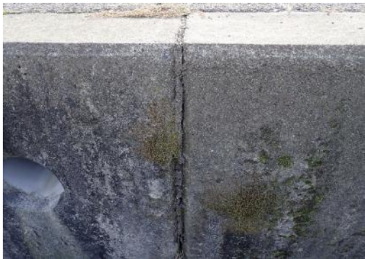
写真IV-2-3 H16-03 擁壁 (既往調査時)
