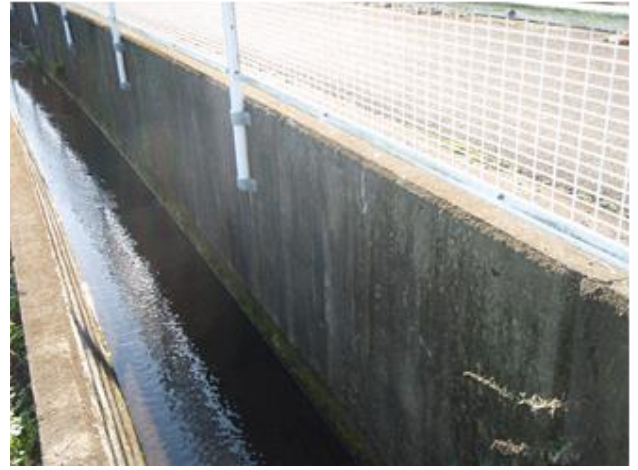
写真Ⅳ-1-4 H16-03 擁壁
