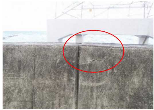
写真IV-2-10 参考:アルカリ骨材反応の 特徴的な状況(2)
