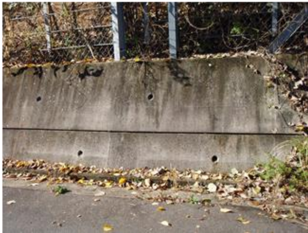
写真Ⅳ-1-5 H17-02 擁壁
