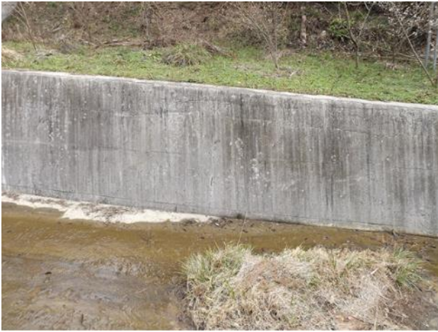
写真Ⅳ-1-3 H17-01 擁壁
