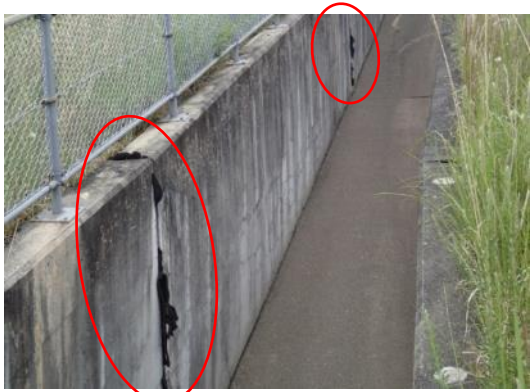
写真IV-2-9 参考:アルカリ骨材反応の 特徴的な状況(1)
