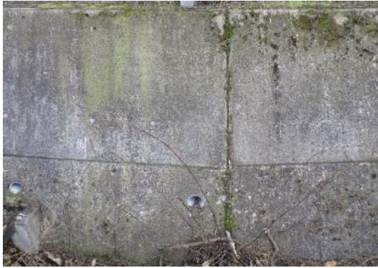
写真IV-2-1 H16-01 擁壁 (既往調査時)
