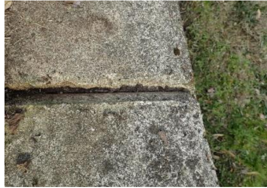
写真IV-2-2 H16-02 側壁 (既往調査時)
