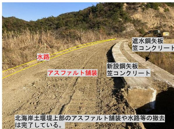
写真3 アスファルト舗装等の撤去後の状況
