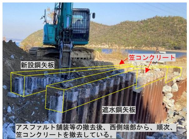
写真4 笠コンクリートの撤去状況
