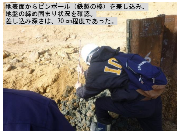
写真8 松島委員立会状況（引抜き跡）
