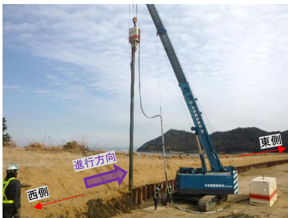
写真5 バイブロハンマによる引抜き状況
