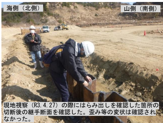
写真7 松島委員立会状況（接手部の確認）
