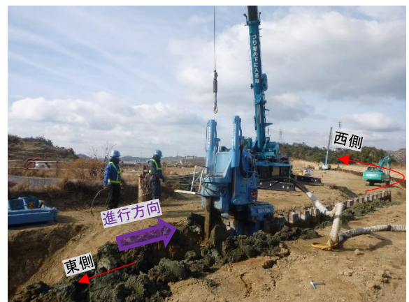
写真6 油圧圧入引抜機による引抜き状況
