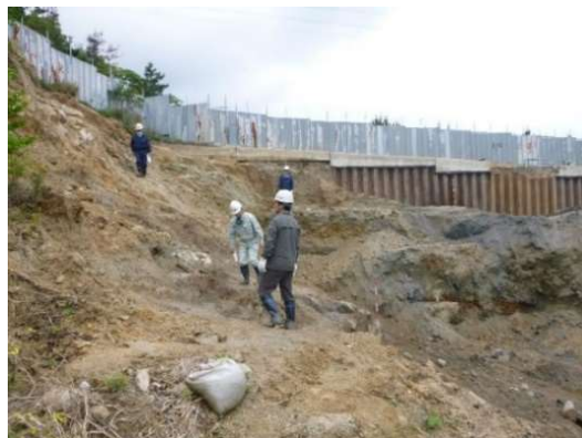
写真 3-1-2-2-3 岩盤部の掘削完了判定の状況
