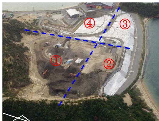
写真3-1-2-3-1 工区分け（平成17年11月撮影）
