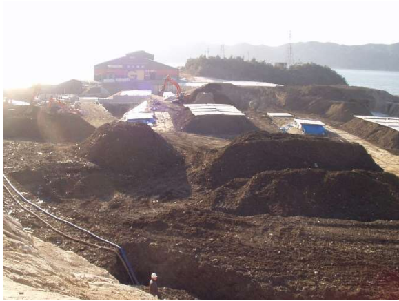
写真3-1-3-2-1 混合面設置状況（平成17年3月）
