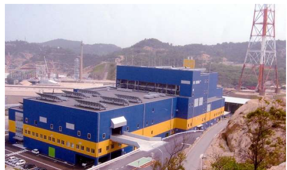
写真３－１－５－１ 中間処理施設
