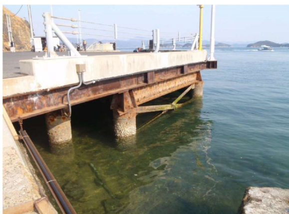
写真3-1-4-4-4 鋼材の状況（直島専用棧橋）
