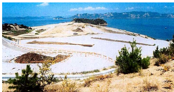
写真2-2-3-3-1 透気・遮水シートの敷設状況
