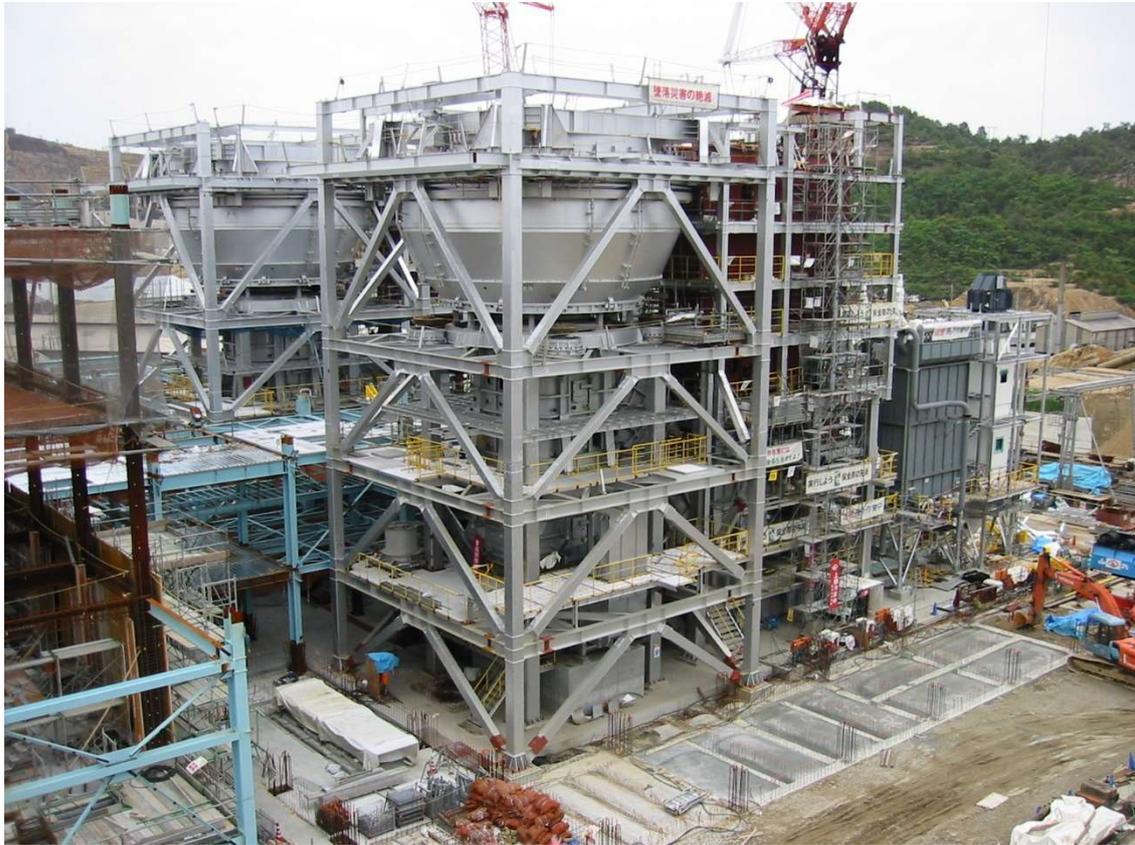
写真 7-5-29 中間処理施設 溶融炉
