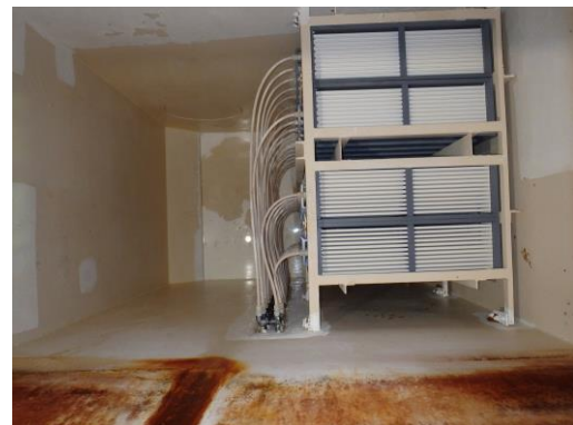
写真 2 セラ膜 No, 2 (薬品洗浄後)
