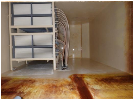
写真 1 セラ膜 No, 1 (薬品洗浄後)
