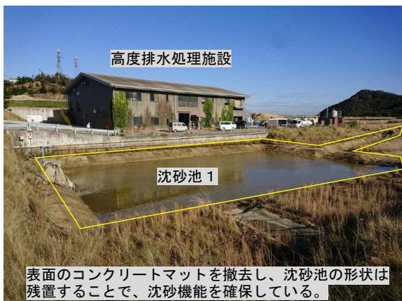
写真1 沈砂池1の撤去後の状況
