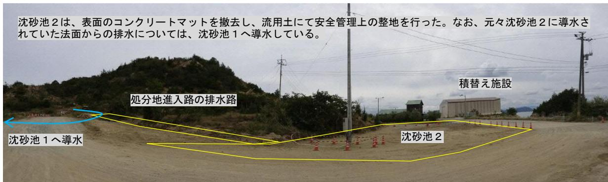
写真3 処分地進入路の排水路及び沈砂池2の撤去後の状況
