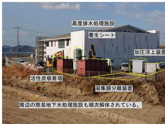
写真9 簡易地下水処理施設の撤去状況とシート養生状況
