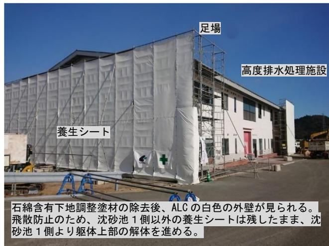
写真8 石綿除去後の外壁と東側の足場の撤去
