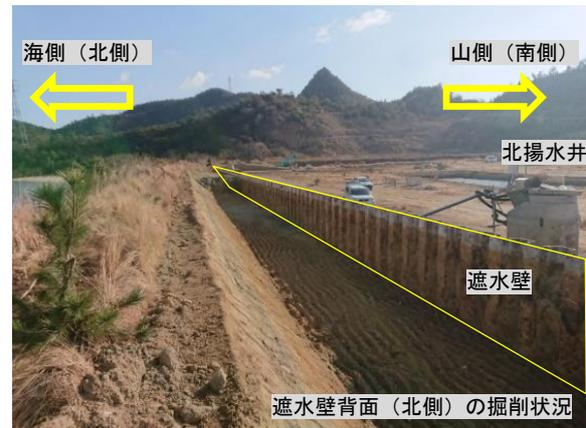
写真 2 引抜き前の状況(中央から東向き)
