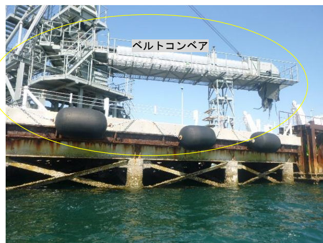
写真15 ベルトコンベア（海側からの状況） 【撤去前】
