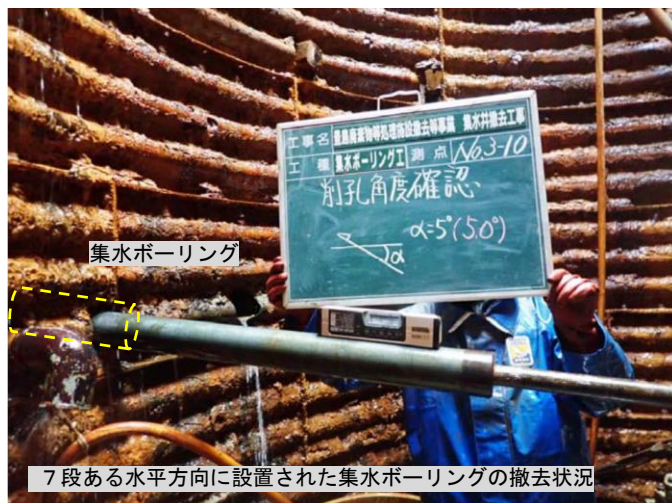
写真4 集水井内の作業
