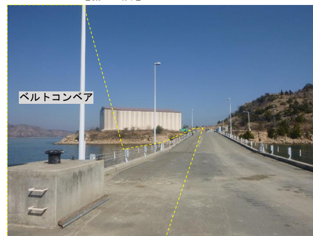
写真17 ベルトコンベア（海側→陸側向き） 【撤去後】
