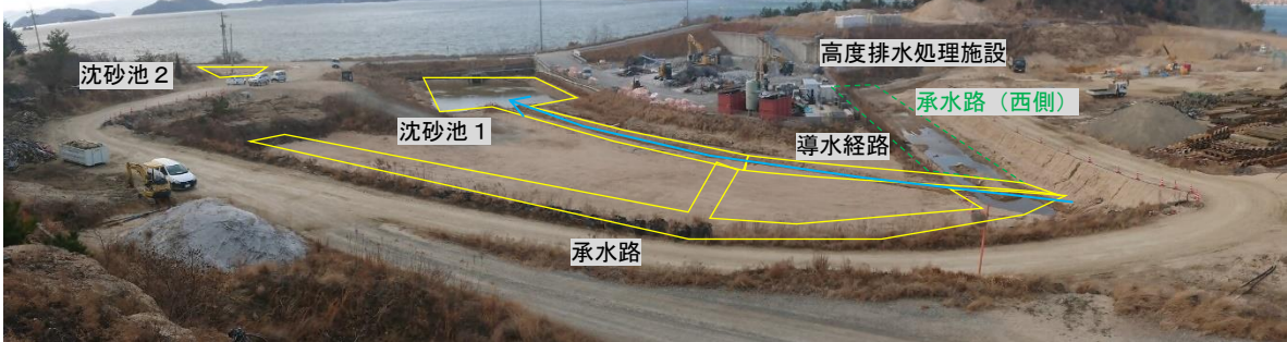
写真1 承水路の撤去後の状況
