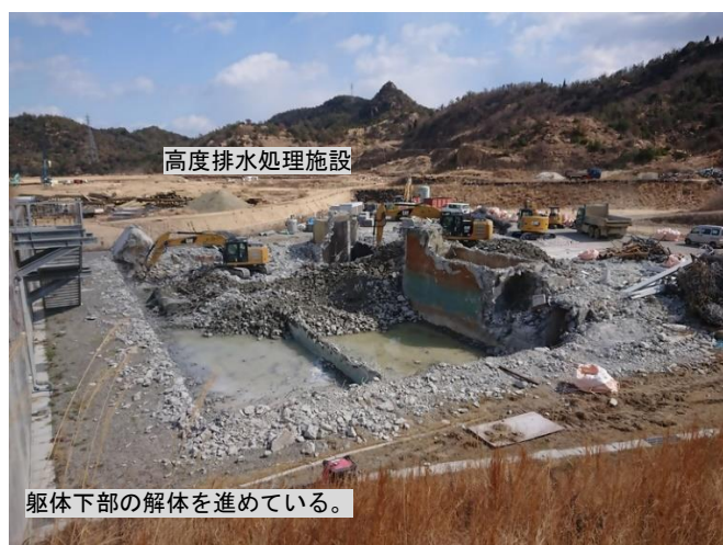
写真5 躯体の撤去状況
