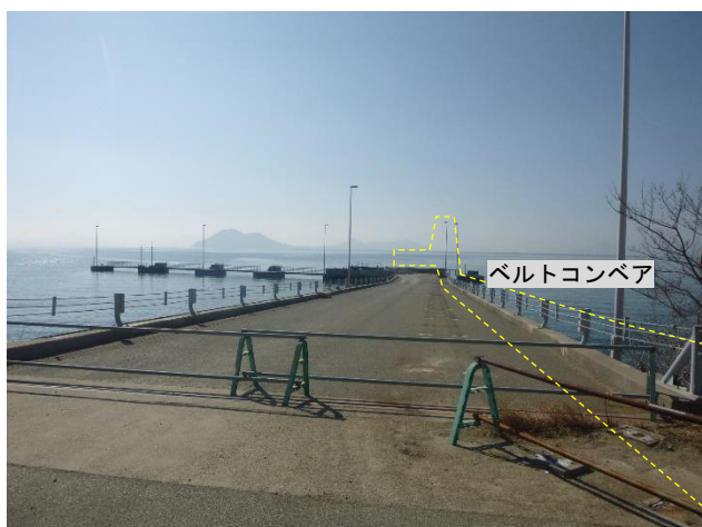
写真16 ベルトコンベア（陸側→海側向き） 【撤去後】
