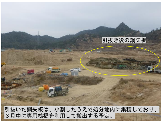
写真 13 鋼矢板の処分地内集積状況
