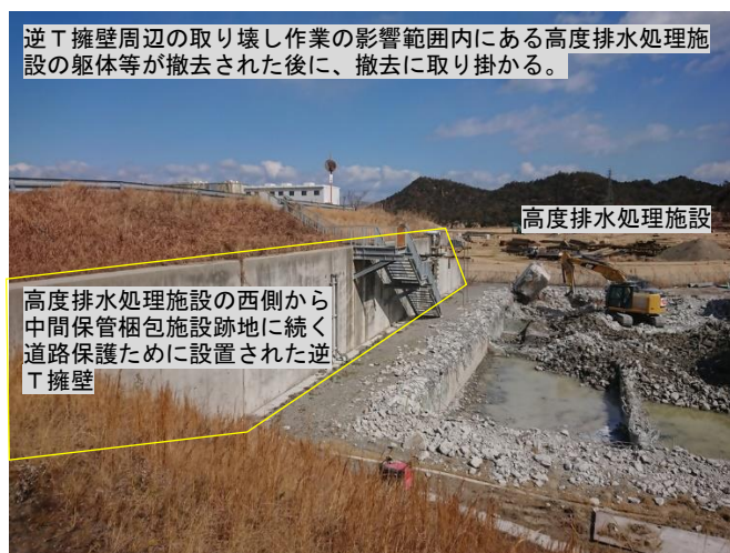
写真8 逆T擁壁の周辺状況
