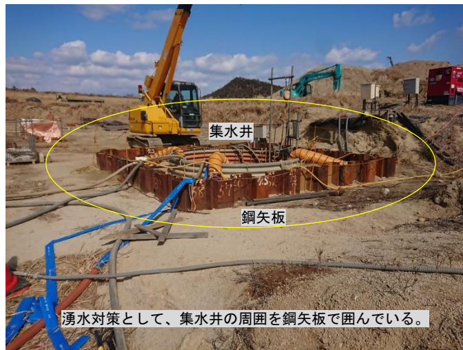
写真3 集水井の作業
