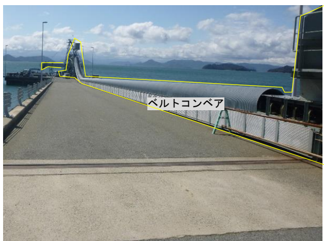
写真14 ベルトコンベア（陸側→海側向き） 【撤去前】
