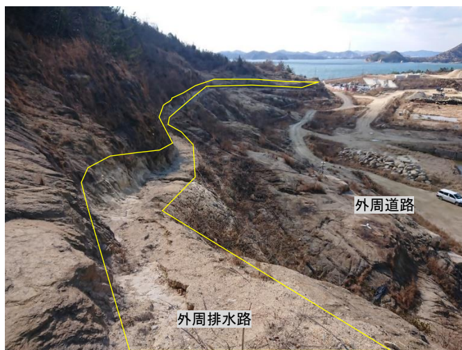
写真2 上流側の排水路の撤去後の状況
