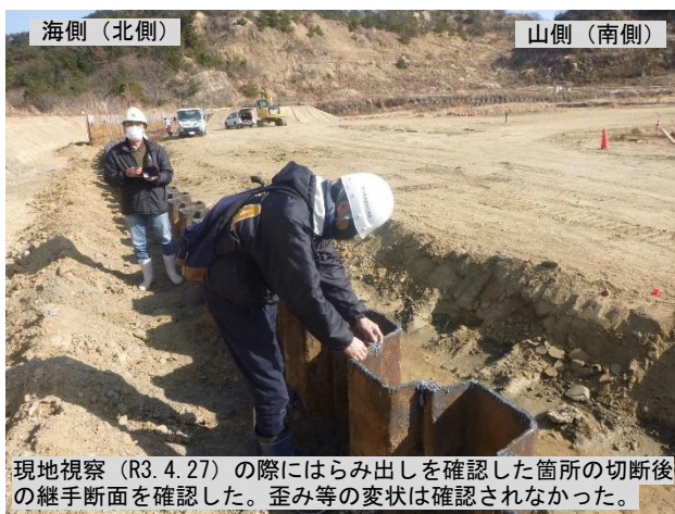
写真 11 松島委員立会状況（接手部の確認）
