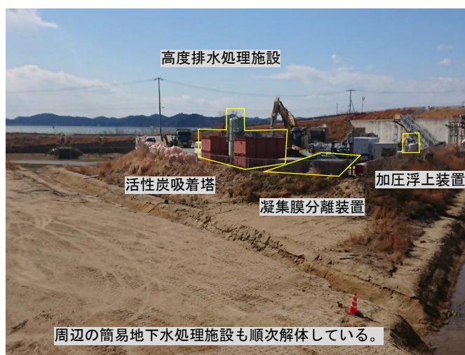
写真6 簡易地下水処理施設の撤去状況
