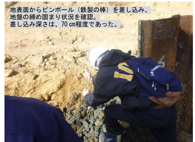
写真 12 松島委員立会状況（引抜き跡）
