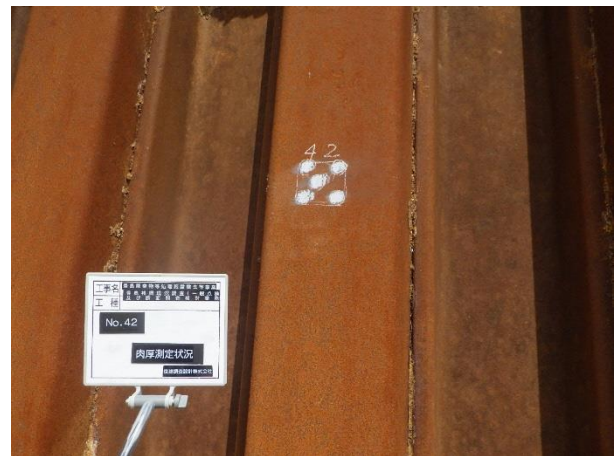
写真 6 肉厚測定箇所-研磨後 (No. 42)
