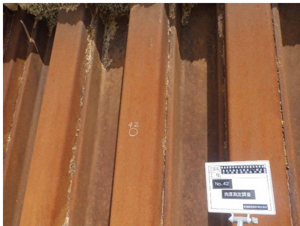
写真 5 肉厚測定箇所-研磨前 (No. 42)
