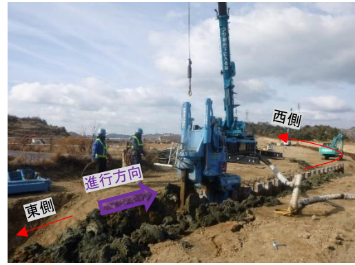
写真2 油圧圧入引抜機による引抜き状況
