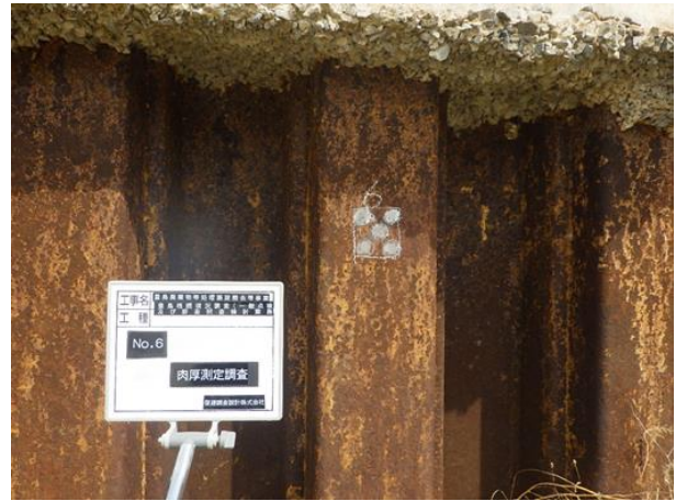
写真 2 肉厚測定箇所-研磨後 (No. 6)
