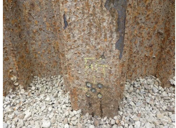
写真12 肉厚測定箇所-研磨後 (FG 中間付近)
