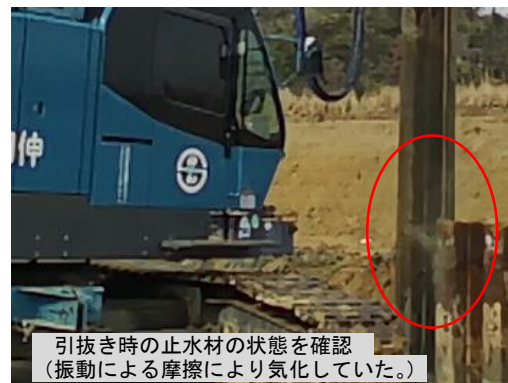
写真5 引抜き時の止水材の気化状況
