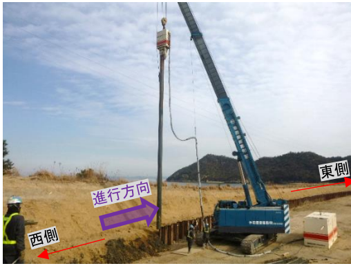
写真1 バイブロハンマによる引抜き状況
