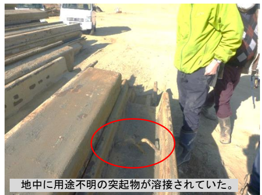
写真6 鋼矢板側面に溶接された金具
