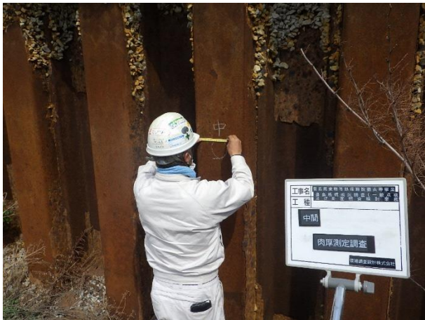
写真 3 肉厚測定箇所-研磨前 (中間)
