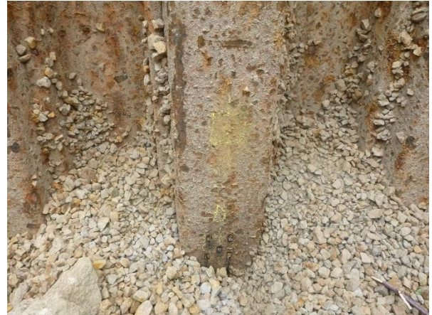
写真8 肉厚測定箇所-研磨後 (D 測線付近)
