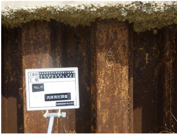
写真 1 肉厚測定箇所-研磨前 (No. 6)
