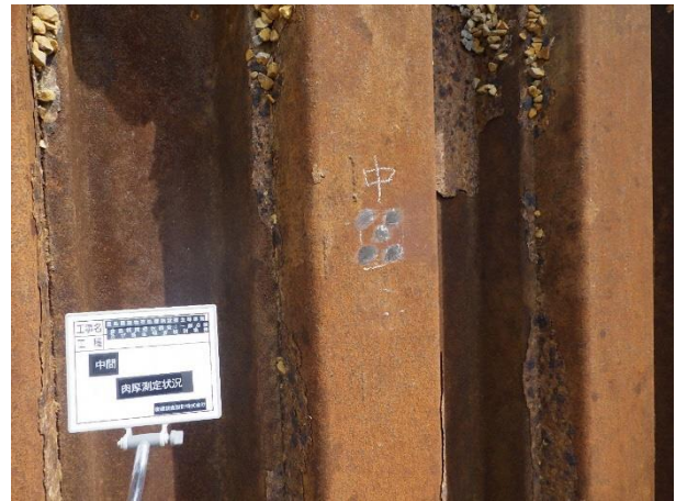
写真 4 肉厚測定箇所-研磨後 (中間)
