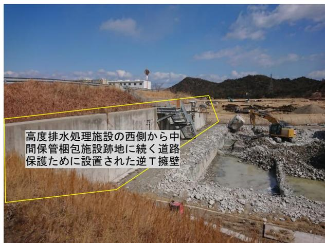
写真2-2 逆T擁壁の撤去前の状況
