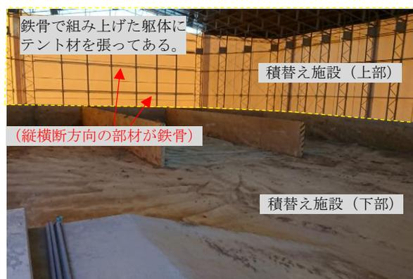
写真1 積替え施設の構造の状況
