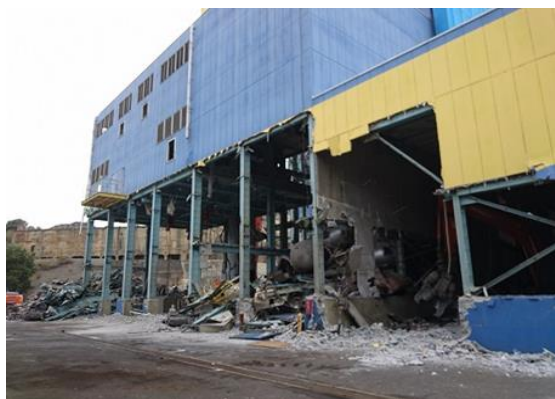
①外装解体中（南東側から） H30. 10. 23
