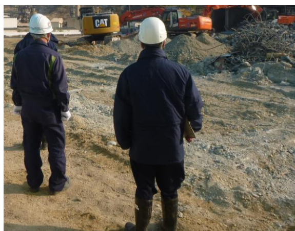
②解体撤去の状況の確認 (北西より撮影)
