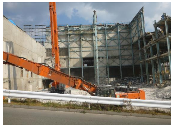
④外装解体中（西側から） H30. 11. 20
