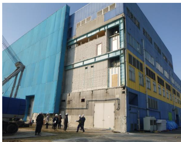
④有効活用を予定している施設の状況の確認 (南東より撮影)
