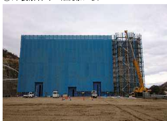
⑥外装補修中（南側から） H31. 2. 8
