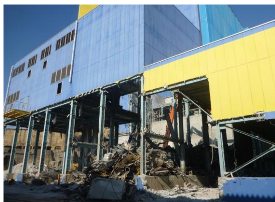
③外装解体中（南東側から） H30. 11. 6
