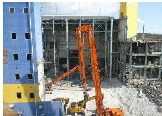
②外装解体中（西側から） H30. 10. 29
