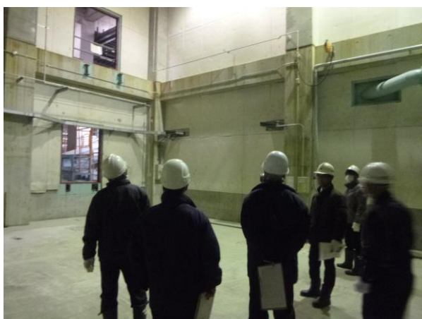
①有効活用を予定している施設の状況の確認 (粗破碎機室)
