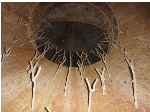
③キルンガス冷却室(内部) H30. 6. 12 撮影
