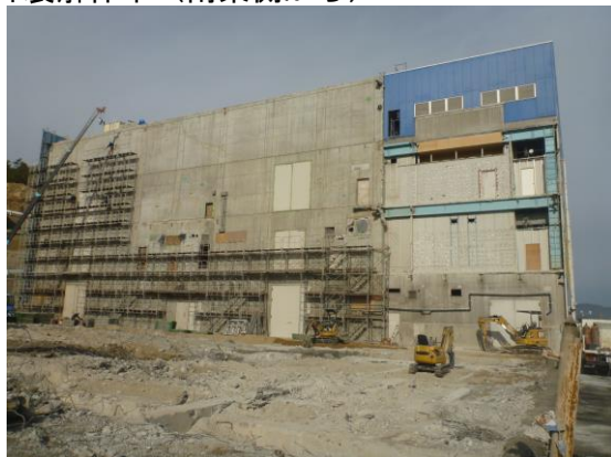
⑤外装解体完了（南東側から） H30. 12. 11
