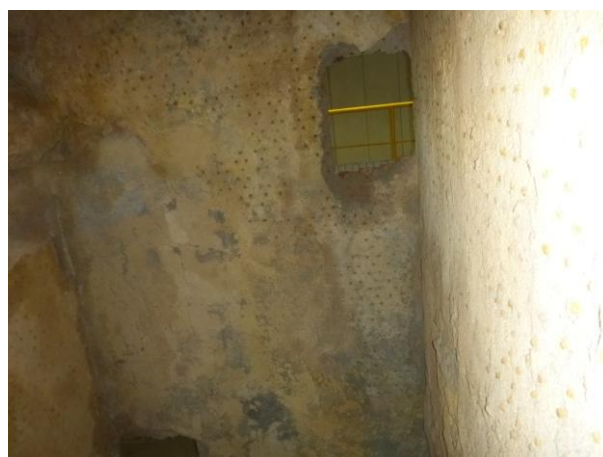
④ボイラー(内部) H30. 6. 12 撮影
