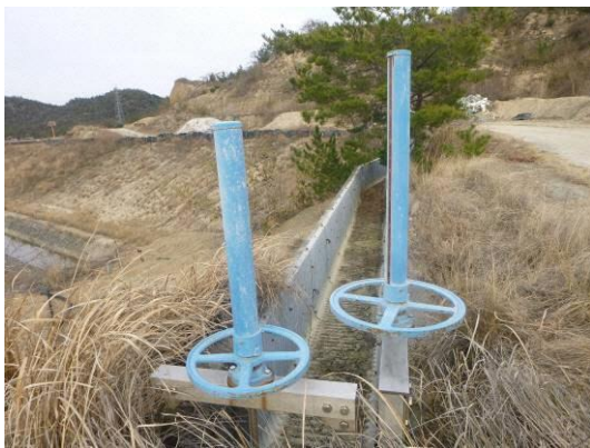
写真1 処分地進入路の排水路
