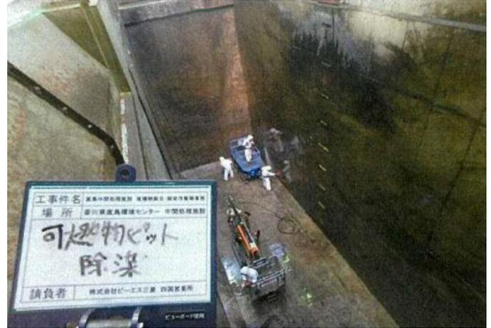
研り作業による底面除去・除染作業中
