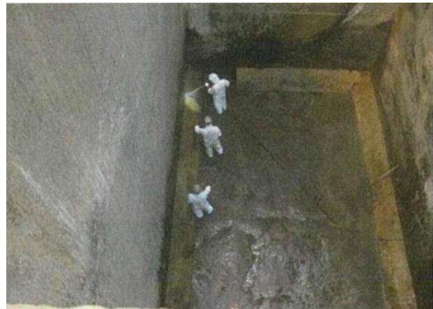
研り作業による底面除去・除染作業中
