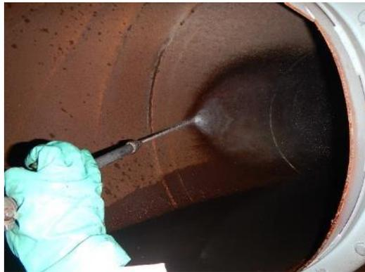
高圧洗浄による配管内除染作業中
