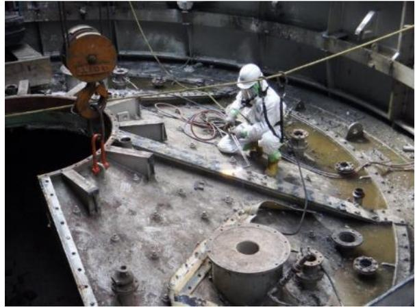
溶融炉上部（ガス溶断中）
