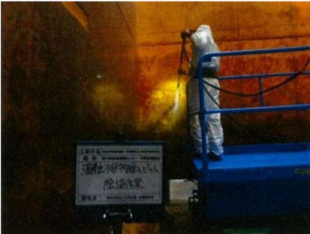
高圧洗浄によるピット内除去・除染作業中
