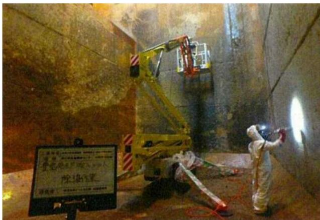
吸引装置による底面付近除去・除染作業中
