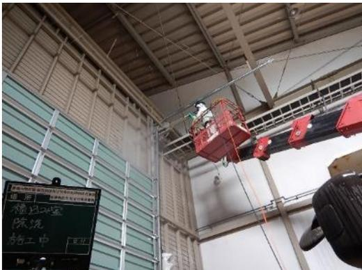
高所作業車による除染作業中
