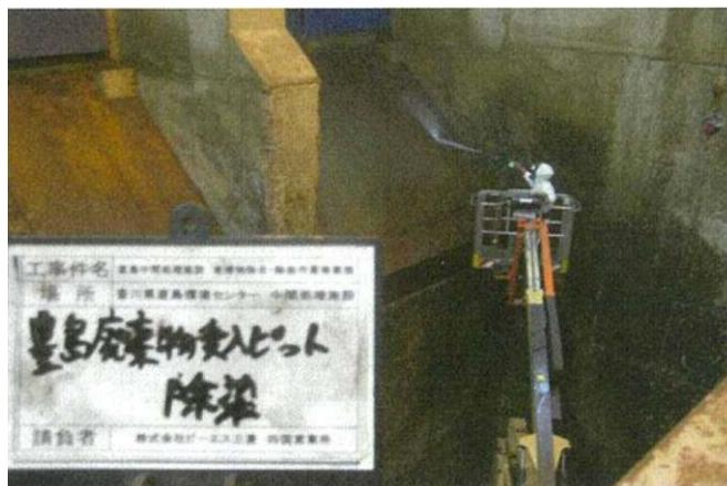
高圧洗浄による投入口付近除去・除染作業中
