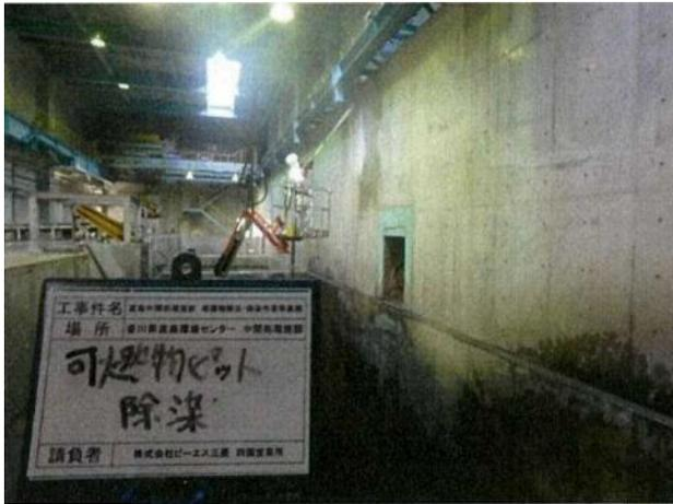
高圧洗浄による壁面除去・除染作業中
