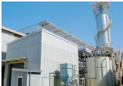
溶融飛灰再資源化施設
