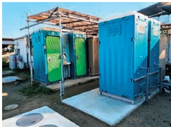
住環境整備支援（トイレ増設）
