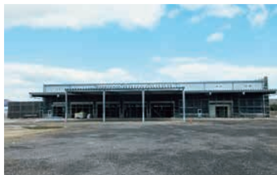
整備中の集出荷施設
