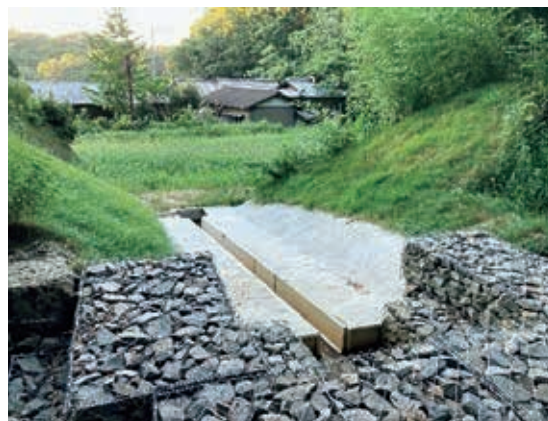
ため池の廃止（綾川町 小谷池）
