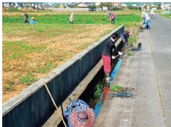
水路の泥上げ
