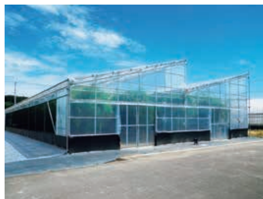
NNハウス(片屋根・連棟型ハウス)
