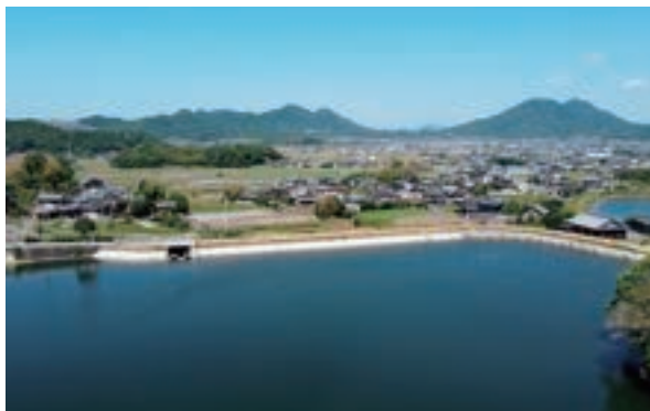
防災対策後のため池
