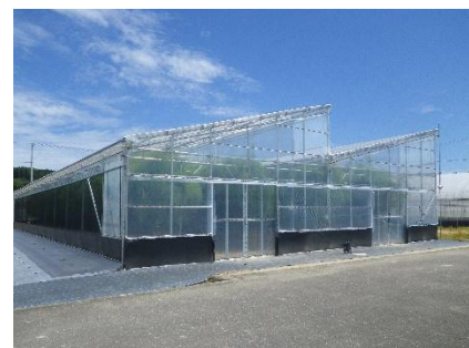
NNハウス（片屋根・連棟型ハウス）
