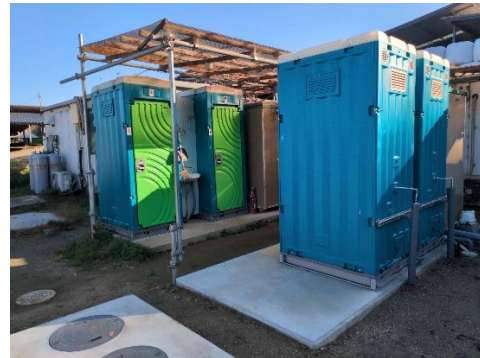
住環境整備支援（トイレ増設）
