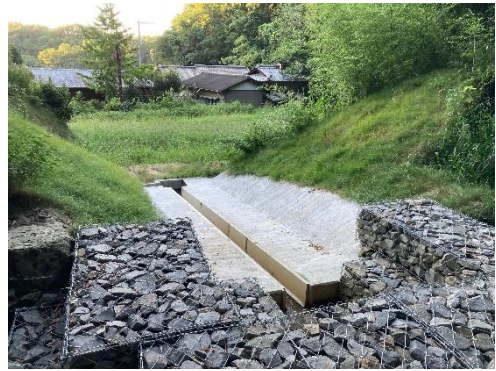
ため池の廃止（綾川町 小谷池）
