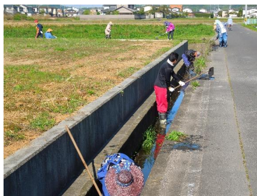
水路の泥上げ
