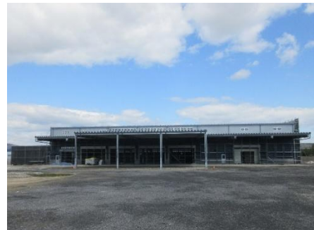
整備中の集出荷施設
