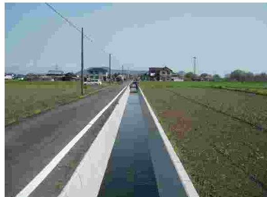
農業水利施設の長寿命化（水路の補修）
