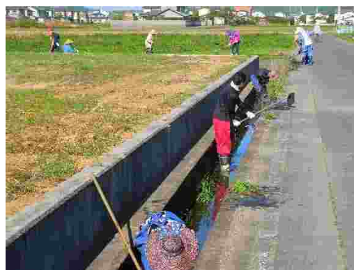
水路の泥上げ
