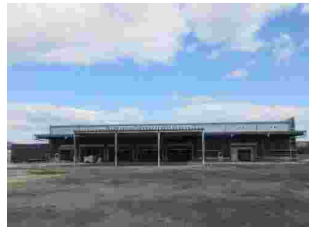
整備中の集出荷施設
