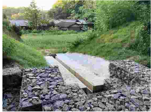
ため池の廃止（綾川町 小谷池）
