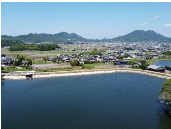
防災対策後のため池
