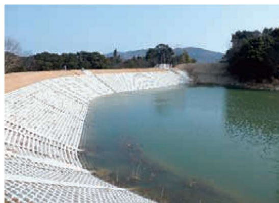
ため池の整備（東かがわ市 奥晴西上池）
