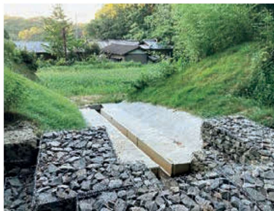
ため池の廃止（綾川町 小谷池）
