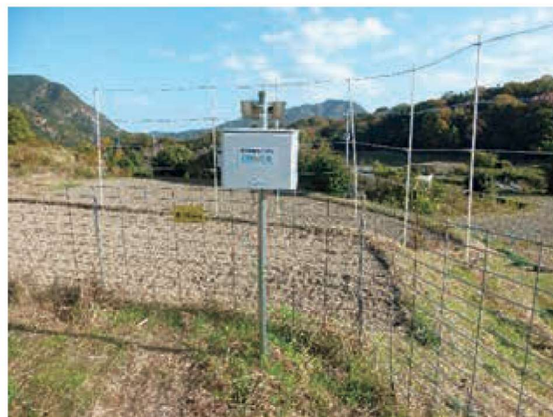
電気柵監視システム
