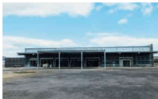
整備中の集出荷施設
