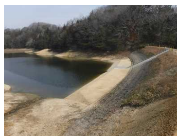
耐震対策後のため池
