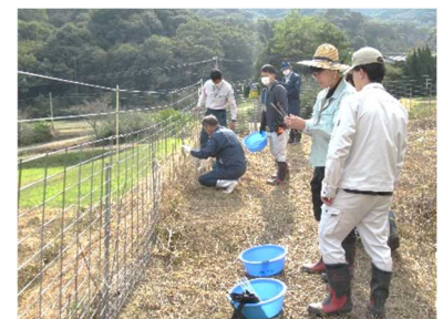
侵入防止柵の補強
