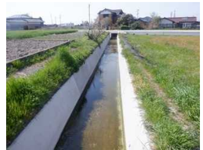
長寿命化対策後の基幹水路
