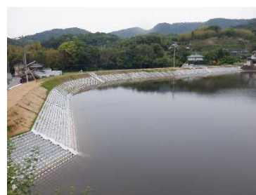
老朽対策後のため池
