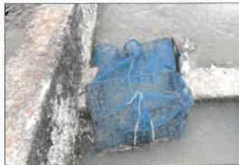
侵入防止ネットの設置
