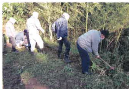
住民が協力しながら柵の修繕活動
