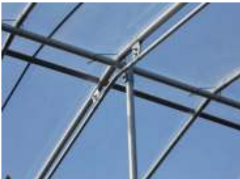
ダブルアーチ補強
