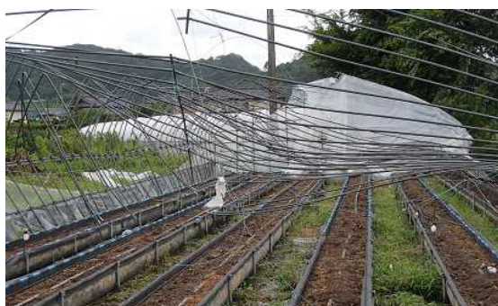
台風11号による施設の被害状況
