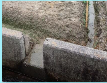
②落水口への確実な連結
