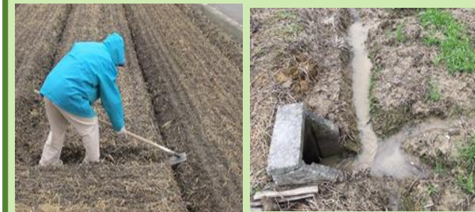
排水溝の補修 排水溝と落水口の連結
