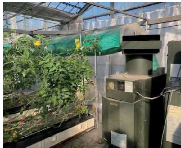
炭酸ガス発生装置 ネポン CG-554T 周囲ダクト連動
