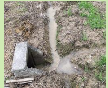
排水溝と落水口の連結
