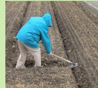
排水溝の補修
