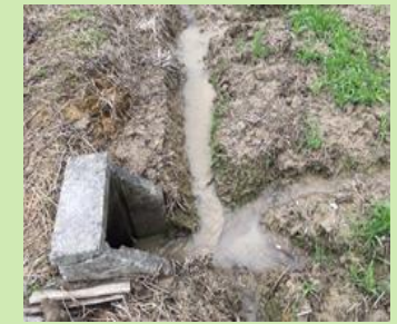
排水溝と落水口の連結
