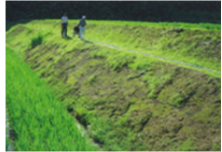
法面の小段設置
