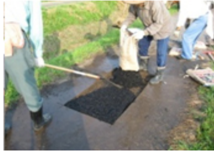
農道舗装の補修
