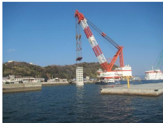
防波堤（ケーソン）の整備
