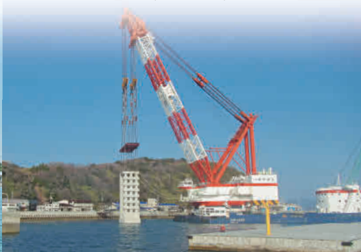
防波堤（ケーソン）の整備
