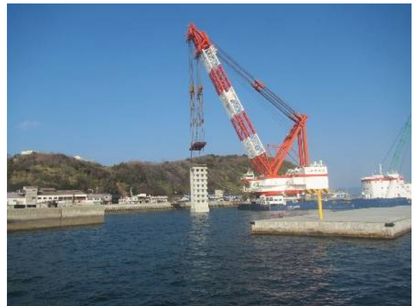
防波堤（ケーソン）の整備
