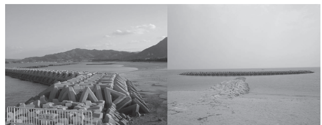
写真5.1 離岸堤配置状況
