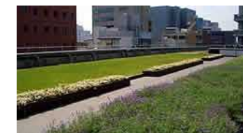
屋上緑化(香川県庁東館)
