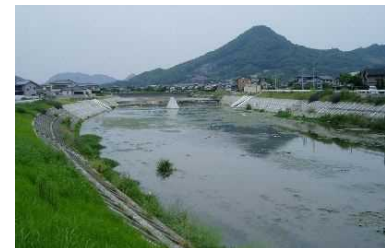
河川改修事業(本津川)
