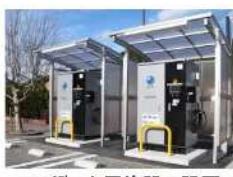
EVバス充電施設の設置
