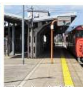
駅舎・ホーム改修
