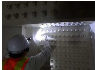
図 4.1 定期点検の様子
