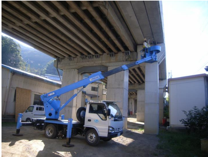
写真-4.1 高所作業車による点検の例
