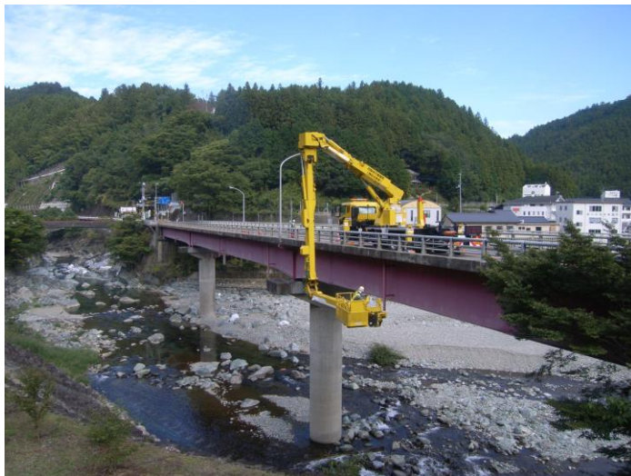
写真-4.1 高所作業車による点検の例
