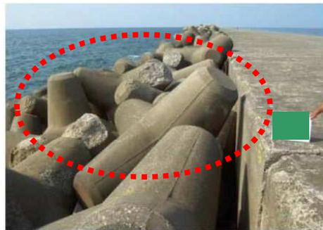
欠損しているブロックがaとcの中間的な変状がある。
