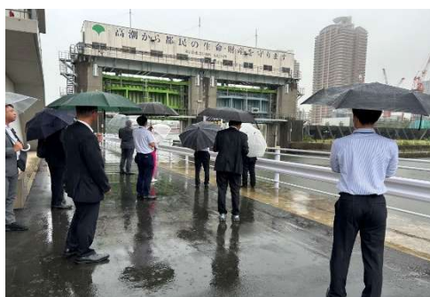
① 防潮堤整備状況
