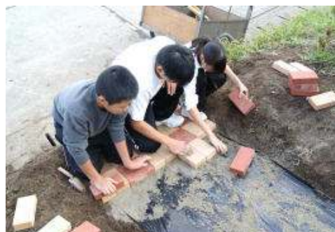
【通路にレンガを敷き詰めていきます】
